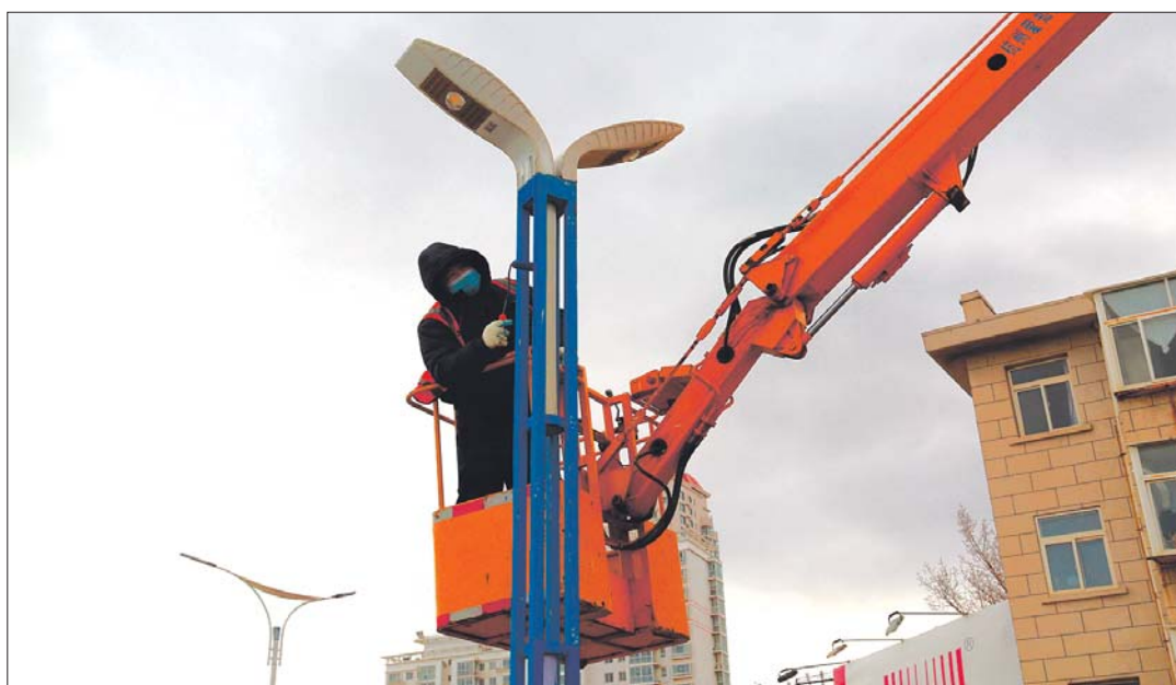
工人开始对滨海一带路灯进行粉刷工作。 通讯员供图
