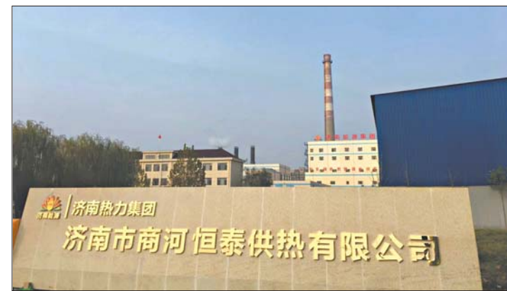
济南能源集团所属热力集团商河恒泰供热有限公司
