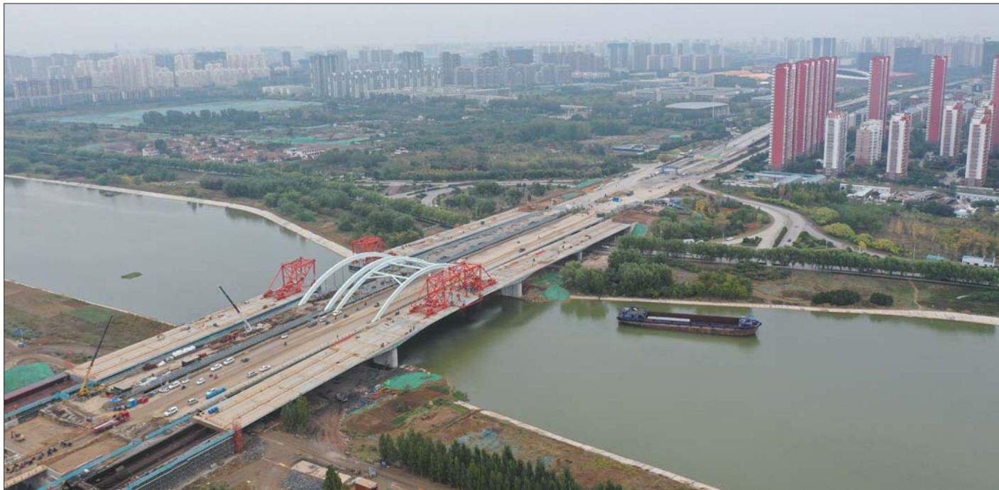
济宁大道京杭运河桥合龙。
