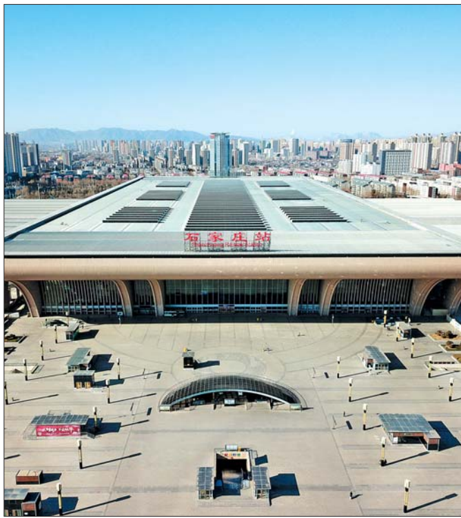
石家庄目前所有车辆及人员均不出市。这是1月7日拍摄的石家庄火车站前广场。新华社发
