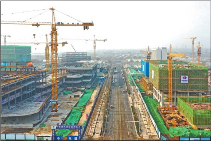
中科新经济科创园内,多栋建筑已封顶。
