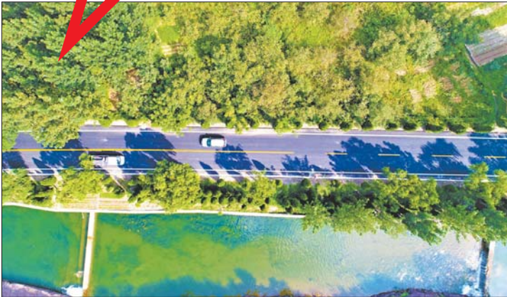
经过整治提升,农村公路颜值大增。
