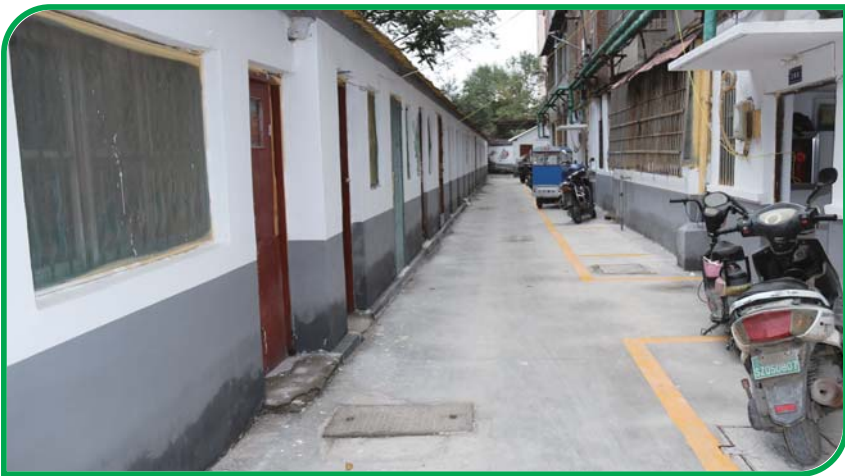
水泥路面取代了原本坑坑洼洼的石板路。
