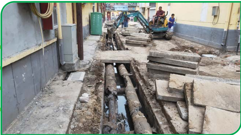
施工期间对小区地下管网重新进行了铺设。
