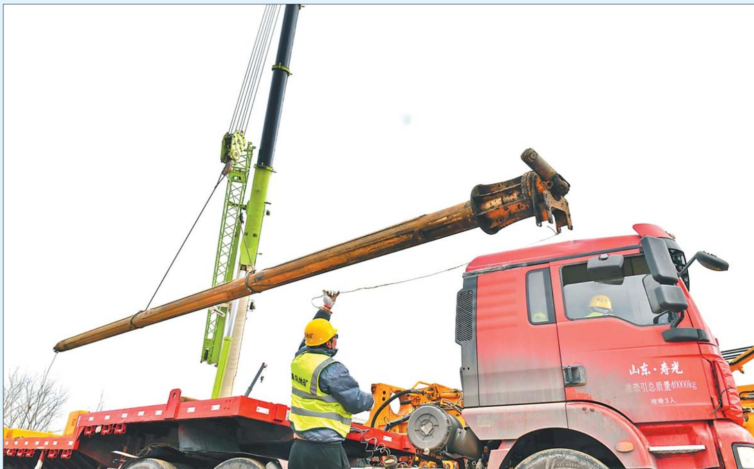
1月20日，救援人员在吊运10号钻孔钻杆。当日15点30分，栖霞笏山金矿爆炸事故救援现场的10号钻孔正式开钻，钻孔口径为710mm，将作为生命救援通道。此外，20日晚上4号钻孔成功透巷5中段，替代3号钻孔作为生命维护监测通道。井下矿工的安全将进一步得到保障。新华社发
