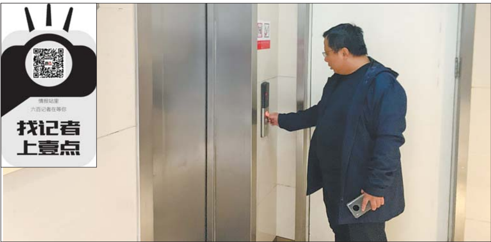
电梯刚刚被修好,但不知哪一刻又出故障不能正常使用了。
