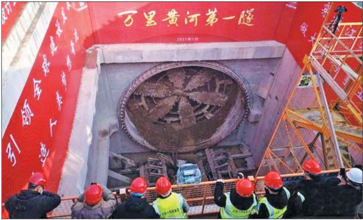
济南落实黄河战略,大力实施北跨。1月23日,被称作“万里黄河第一隧”的济南黄河隧道工程西线隧道胜利贯通。
