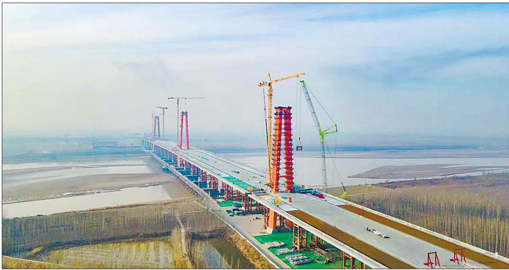
世界最大跨度的济南凤凰黄河大桥项目三塔自锚式悬索桥三塔主体结构全部施工完成。
