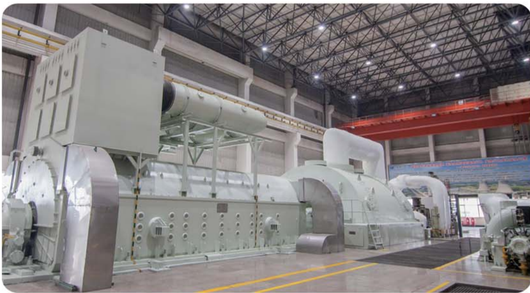
嘉祥电厂#1汽机房。
