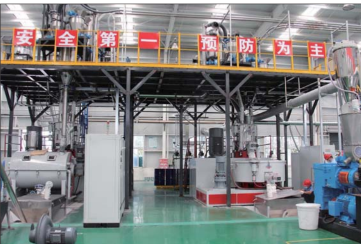
1万吨/年新材料智能生产线启动运行。
