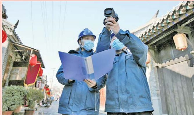
济南供电公司彩虹共产党员服务队队员对百花洲片区供电线路开展巡查。
