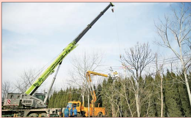
济南供电公司开展10千伏博科线迁改工程大型综合不停电作业。
