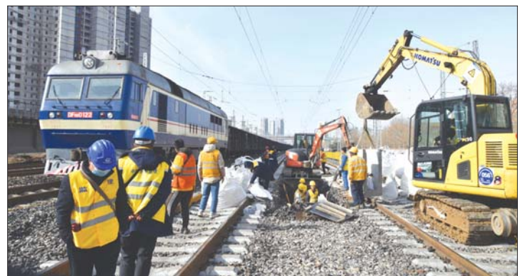
黄台联络线施工现场图 通讯员 张鹏 李明文 摄
