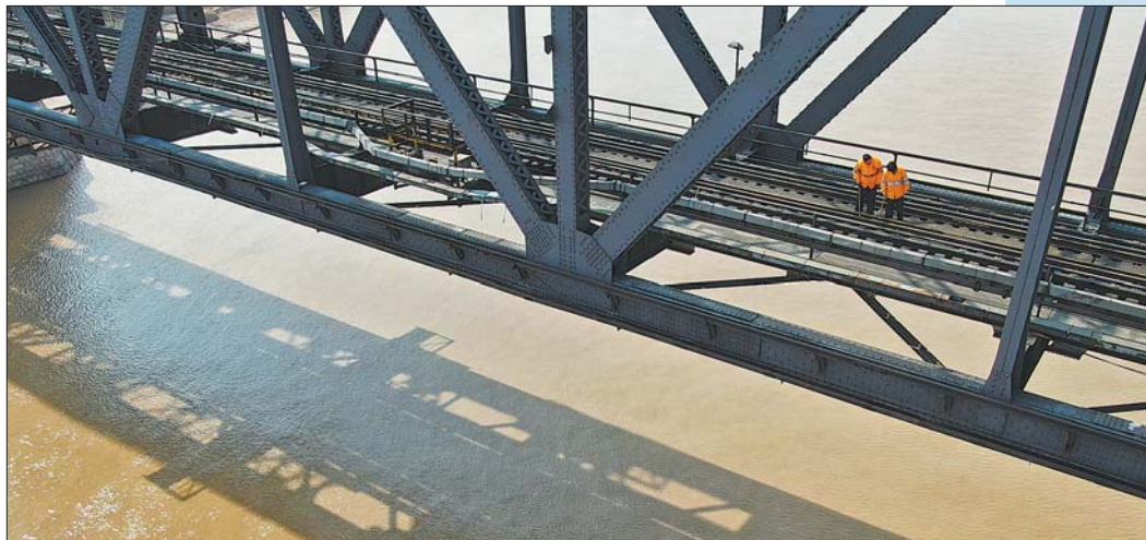
金玉婷跟随父亲上桥检修。
