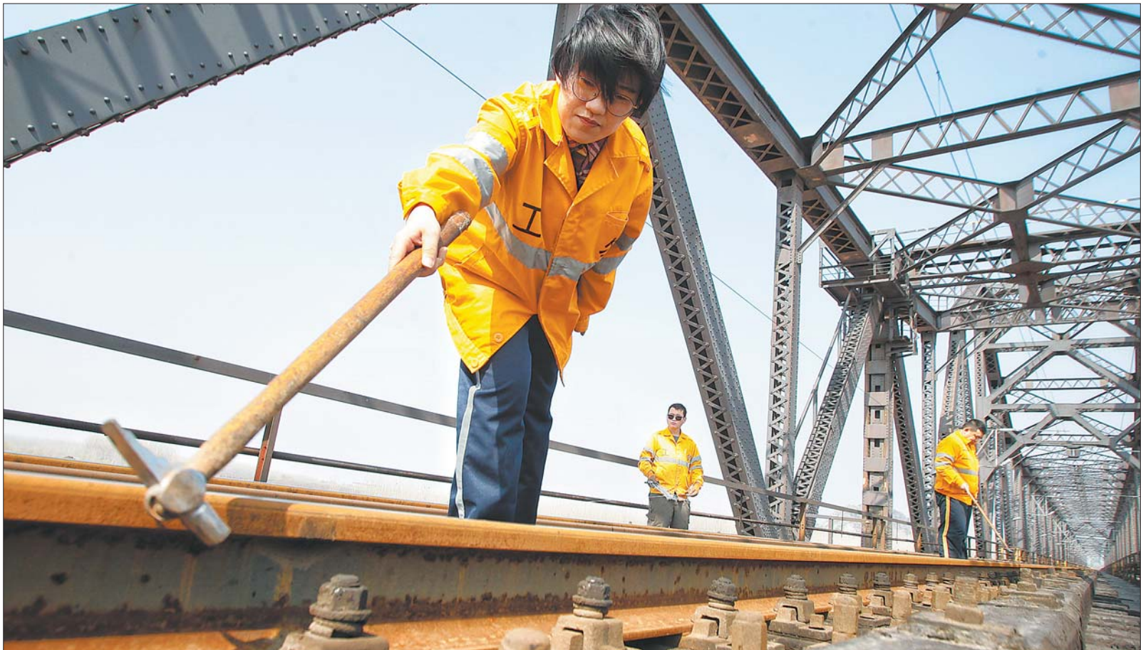
金玉婷用小锤敲击螺栓，判断螺栓是否松动。
