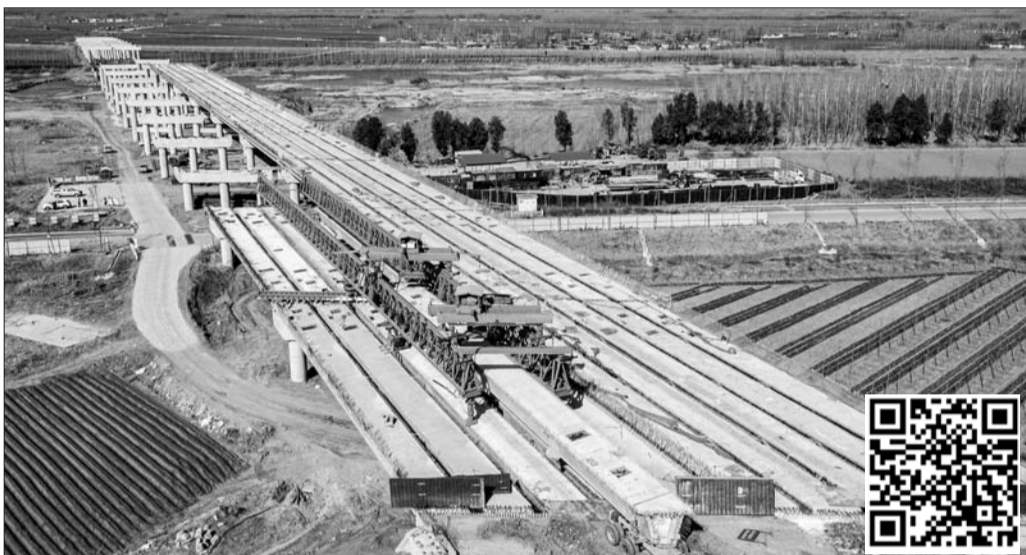
G327曲阜至任城改建工程东段泗河大桥段进展过半。
