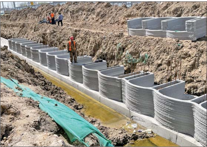
全国首个3D打印河道挡土墙亮相济阳。
