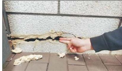
小区外墙裂出近3厘米宽的裂缝。
