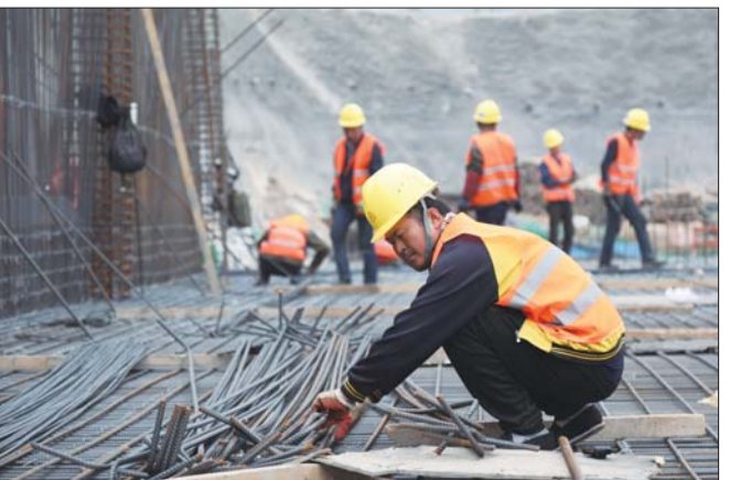
现场工作人员忙施工。
