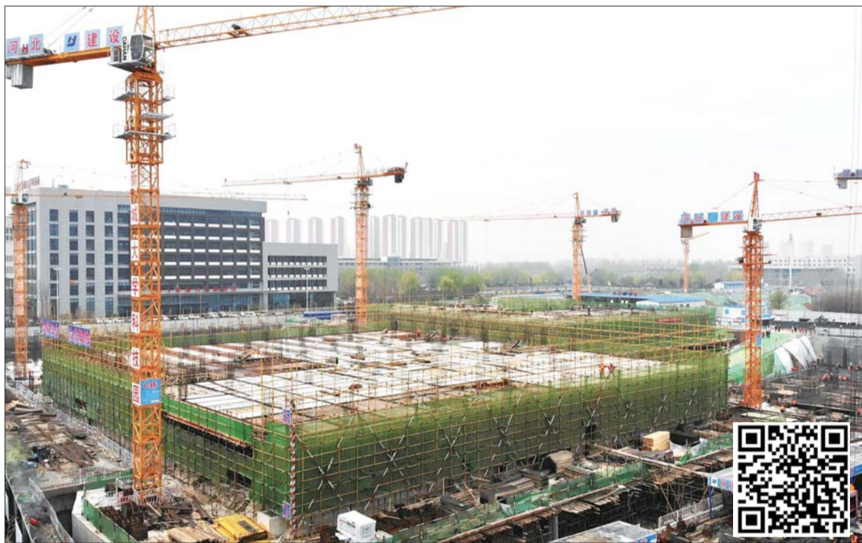
建设中的新城大学科技园二期项目。
