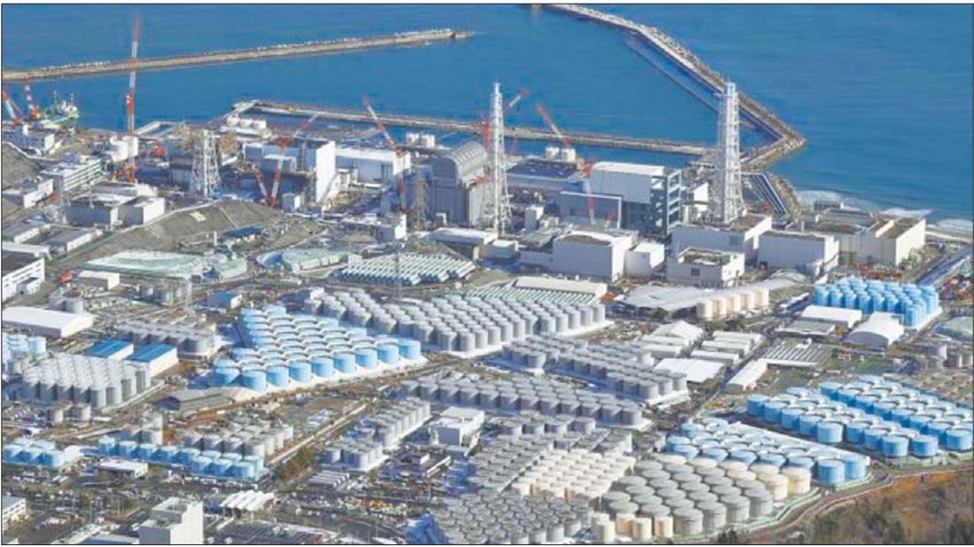
用于存放福岛核废水的储存罐,目前这种罐体已建有1061座。
