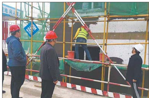
长清区住建局开展建筑施工领域防汛防风检查。
