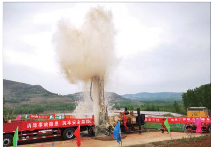
成功打出水井。
