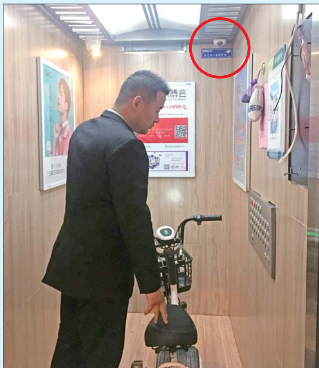
电梯轿厢顶部的白色探头发出警报,禁止电动车进入电梯。
