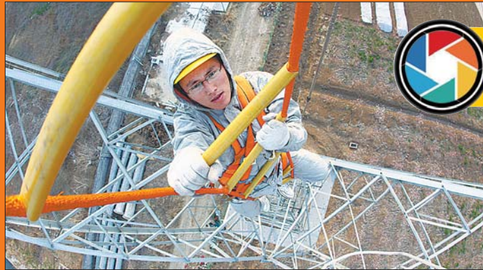
李敏在500千伏邹川线上攀登软梯进入强电场开展带电消缺工作。 (受访者供图)
