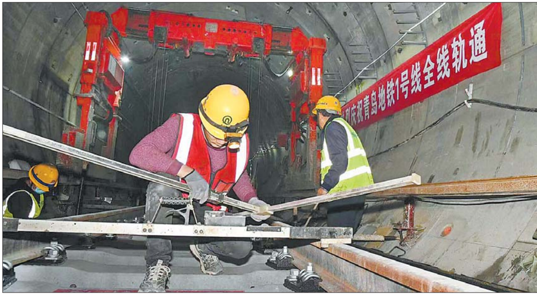
工人在隧道内进行铺轨作业。
