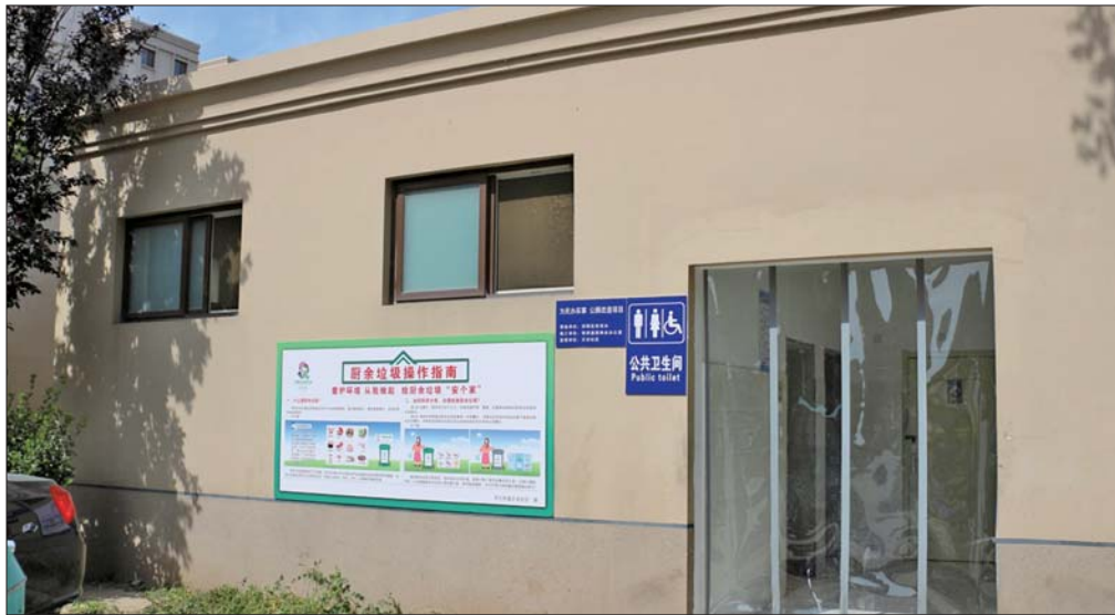
维修后的徐家鑫苑公厕,干净整洁,焕然一新。
