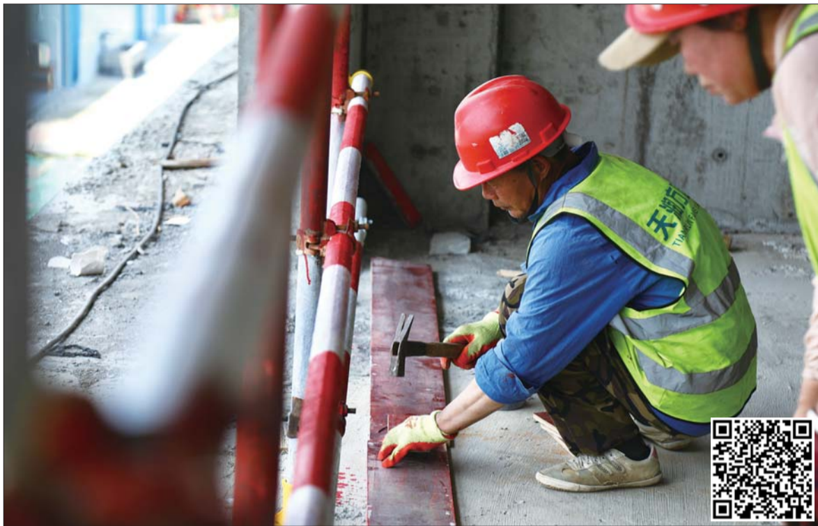
工人刮平夯实地面水泥。
