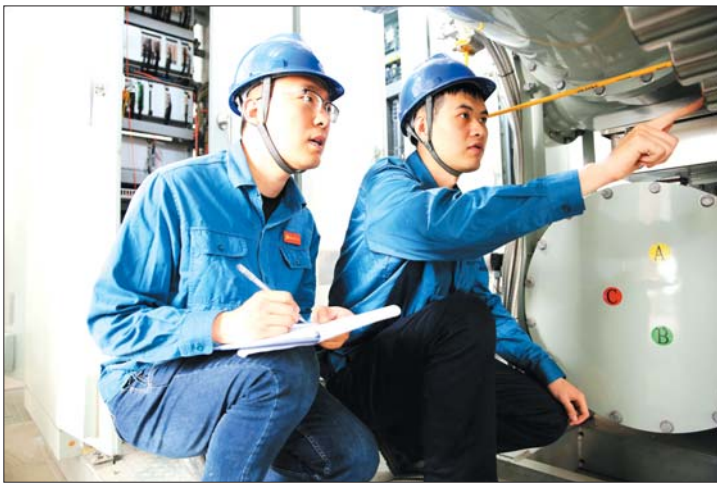
供电员工正在对新建变电站GIS设备进行投运前的巡视和检查。张治林 摄
