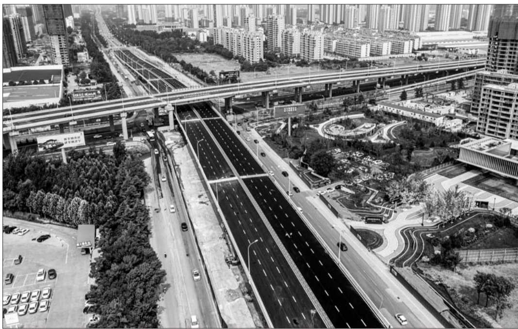
崇文大道跨宁安大道项目航拍场景。
