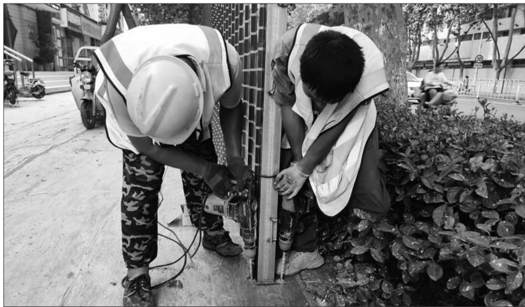
施工人员正在修建挡板。
