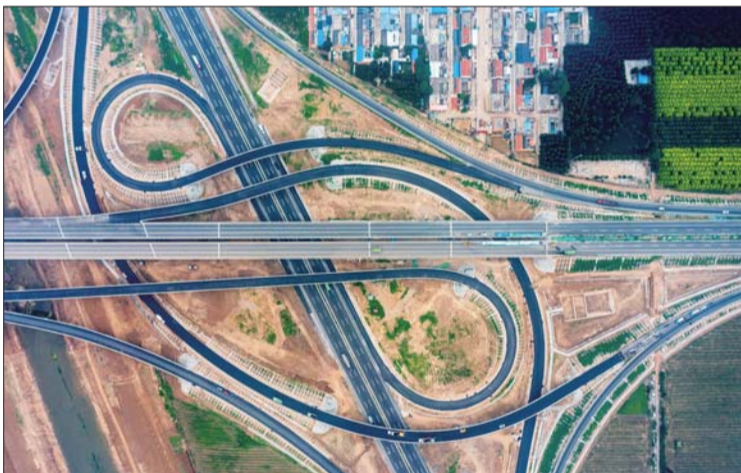
张家楼互通立交航拍。
