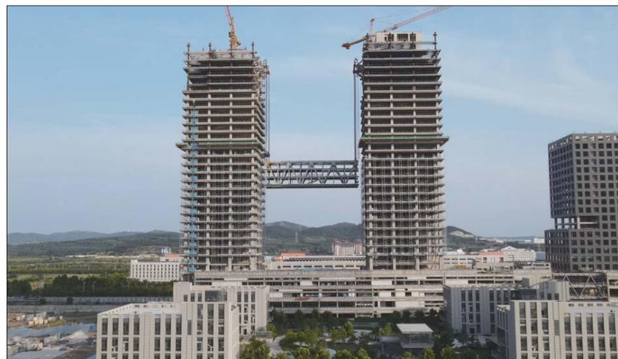
本报讯(记者 王震 通讯员 林靖凯 杨振国 孙珊) 7月5日17时8分,在中建五局投资建设的国家(威海)创新中心,重达1800吨的钢结构空中连廊整体提升至128.05米高空的两座塔楼之间,这标志着项目建设取得重大突破性进展。
