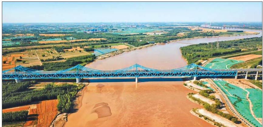
石济客专黄河高铁两用大桥建成后,大大缩短了济南黄河两岸的时空距离。(资料片)
