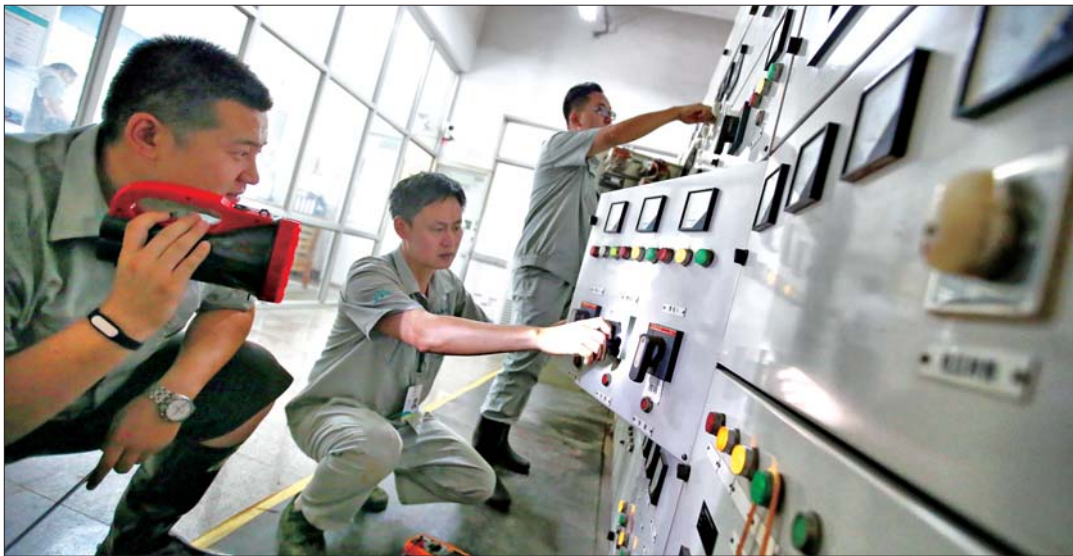
济南水务集团加压供水管理部员工正在进行设备检修。
