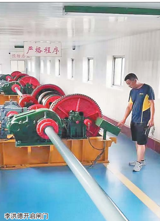
李洪德开启闸门。
