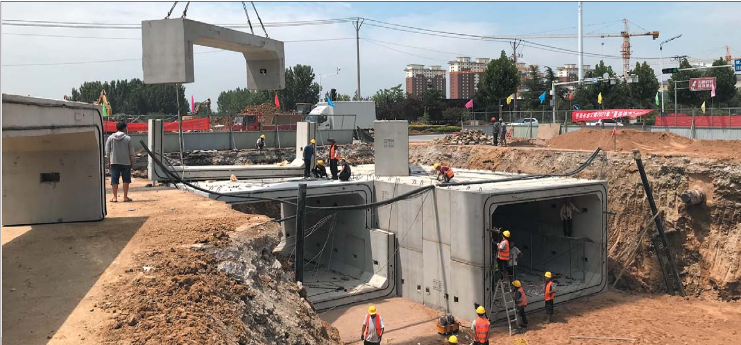
沂南县城主泄洪渠出口采用超常尺寸箱涵改造,单个箱涵内径达3.5米高、6米宽。受访者供图
