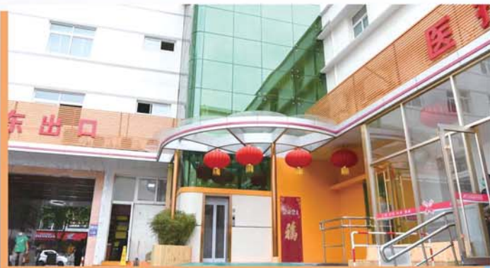
“见缝插针”安装外挂电梯。
