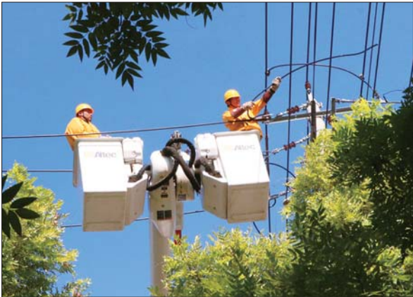
8月24日,禹城公司员工为10千伏水厂线35号杆带电完成断、接引流线工作,保障42家企事业单位和500余户居民正常用电。(韩景茹)
