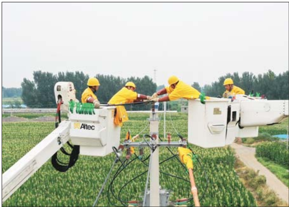
8月19日,平原供电公司带电作业人员在10千伏戴家口22号杆处开展带负荷更换柱上开关作业,经过3个小时连续施工,顺利消除安全隐患。(于洋)
