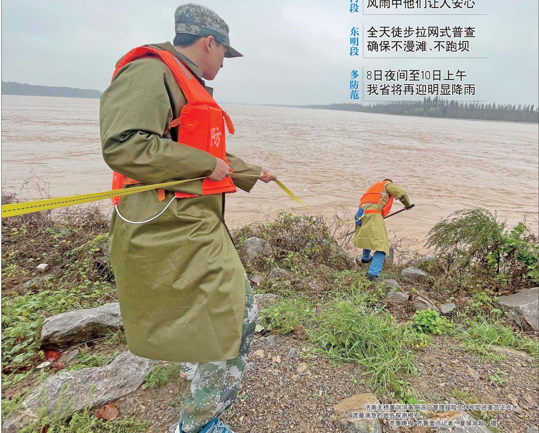
济南天桥黄河河务局冻口管理段险工14号坝巡查员正在水流最湍急的地方探测根石。
