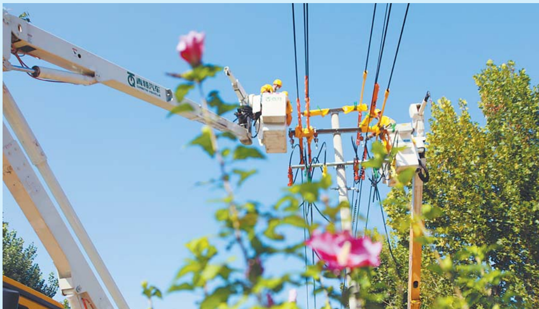
供电员工正在开展带电消缺作业。
