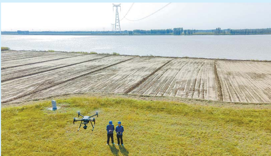
供电员工利用无人机巡视±660千伏银东直流跨黄河处线路。
