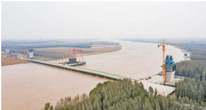
济南大西环项目建设现场。
