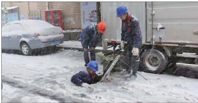
▲东泰热力工作人员冒雪维修供热管线。 齐鲁晚报·齐鲁壹点 记者 于泊升 摄
