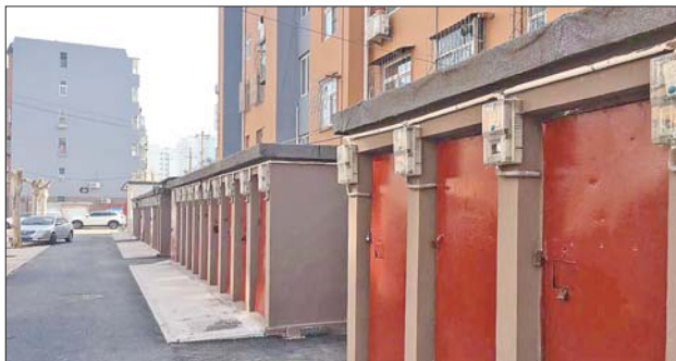
对没有地下室的居民,实行强电入厦措施,为居民的厦子(地上储藏室)安装电表,方便充电。
