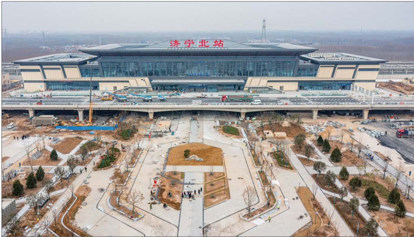
建设中的济宁北站。
