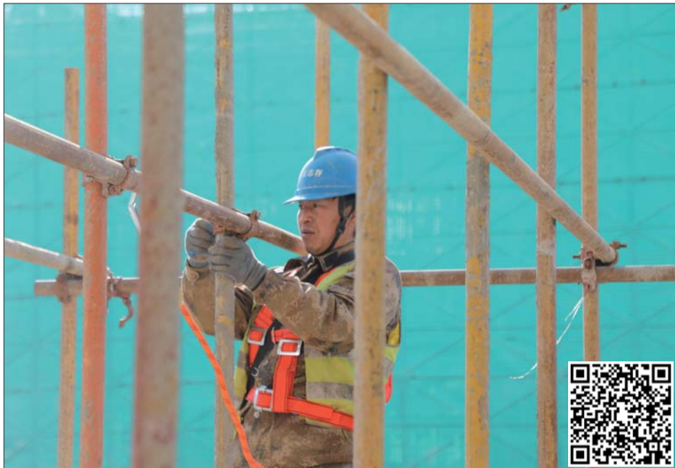
工人正在支设脚手架。
