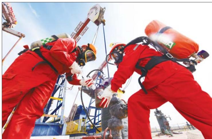
针对含硫化氢油藏气油比高、硫化氢气相腐蚀风险大等开发难点,胜利油田河口采油厂科学有效应对,并率先应用“侧钻段抗硫套管完井+直井段抗硫套管回接”的完井新工艺技术,确保含硫化氢油气藏的油气井投产后一口见效。目前,河口采油厂含硫化氢油气生产井6口,累计增油2527吨、增气140.7万立方米。
