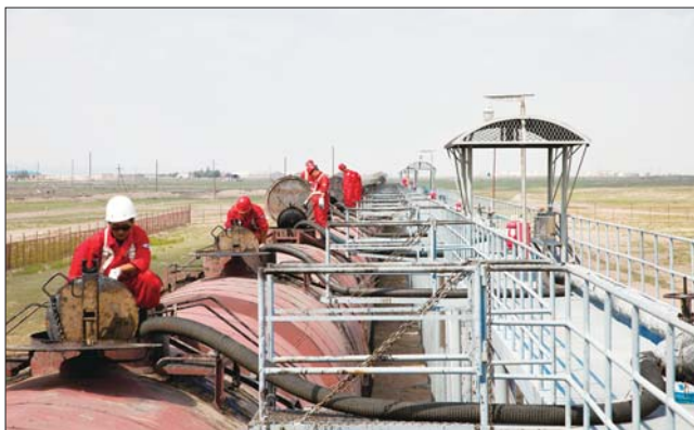
蒙古公司员工正在安装输油管,为装油做准备。
