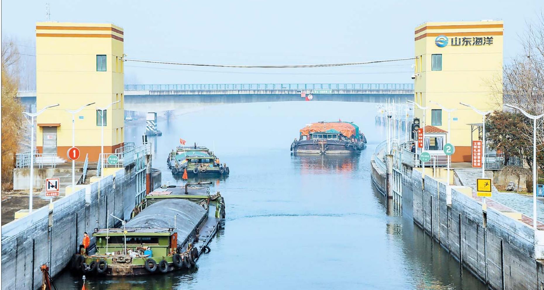
千古运河水悠悠,贯通古今四海走。日前,京杭运河济宁至台儿庄(济宁段)航道“三改二”主体工程、湖西航道(二级坝-苏鲁界)改造工程顺利通过验收,标志着京杭运河济宁以南实现二级航道通航。从此,京杭运河湖东、湖西双线主航道互联互通,由1000吨级三级航道全面提升至2000吨级二级航道,成为省内通江达海的一条黄金运输大动脉。今后,京杭运河济宁段1000至2000吨级船型实载率可提升近60%,2000吨级提升近30%,每年可节省直接物流成本近10亿元。
