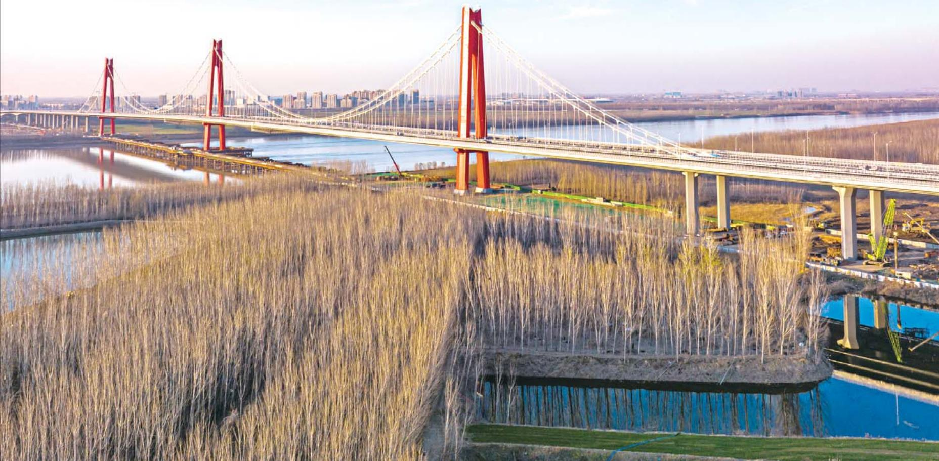
1月18日,济南黄河凤凰大桥正式通车,这是万里黄河最宽大桥,从大桥的南口上桥,驾车4分钟即可通过黄河天堑。该桥采用“公轨同层,轨道居中”的设计方案,除了机动车道,在最外侧还有3米宽的非机动车道和1.75米宽的人行道。未来黄河两岸居民既可选择自驾、公交、轨交过河,也能选择以步行、骑单车的方式通过。
