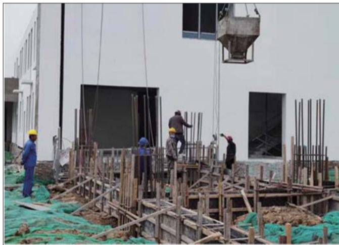
项目施工现场。
