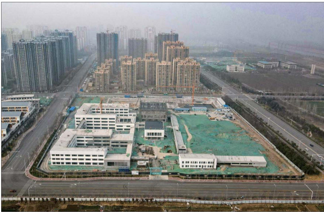
5个单体楼工程都已完成。
